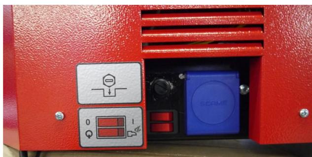
Включением главного выключателя котла горелка автоматически включится в режим готовности. В работу горелка вводится включением выключателя горелки. На основе требования поставки тепла горелка зажигается и сжигает пелеты до тех пор пока термостат не даст команду к выключению.
